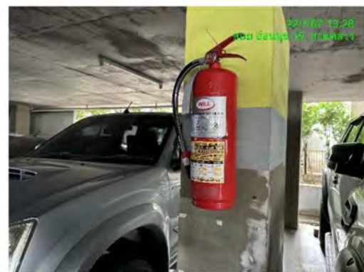
ภาพที่ 2-62 เครื่องดับเพลิงมือถือชนิดผงเคมีแห้ง บริเวณอาคารจอดรถ ชั้นละ 2 จุด
