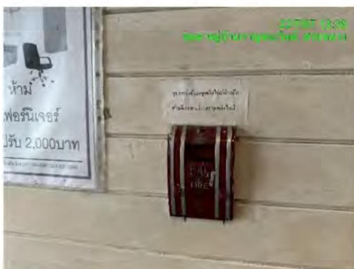
ภาพที่ 2-56 อุปกรณ์แจ้งเหตุสัญญาณเตือนเพลิงไหม้ในอาคาร
