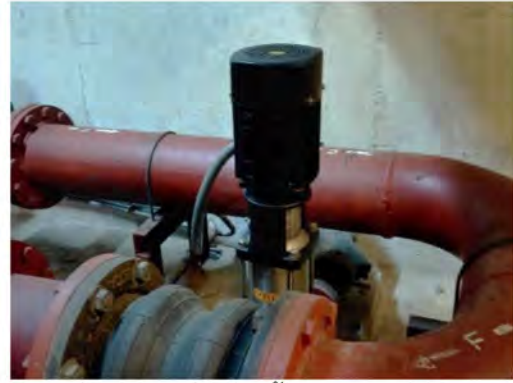
ภาพที่ 2-58 เครื่องสูบน้ำรักษาแรงดัน
