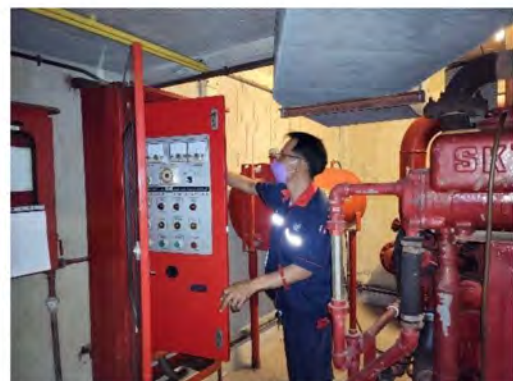
ภาพที่ 2-67 การตรวจสอบและบำรุงรักษาปั้มน้ำดับเพลิง
