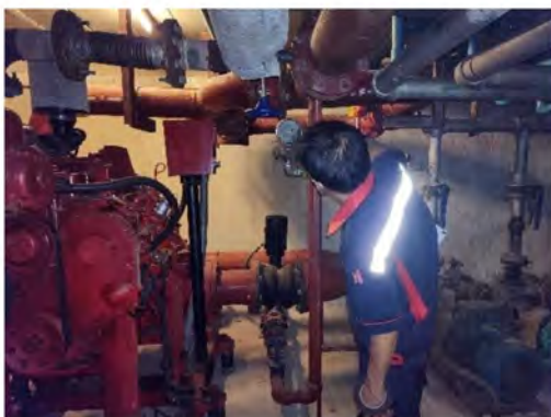
ภาพที่ 2-67 การตรวจสอบและบำรุงรักษาปั้มน้ำดับเพลิง
