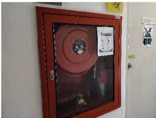
ภาพที่ 2-61 ตู้เก็บสายฉีดน้ำดับเพลิงในอาคารจอดรถ
