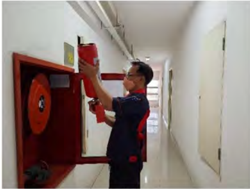
ภาพที่ 2-64 การตรวจสอบประสิทธิภาพของเครื่องมือและอุปกรณ์ดับเพลิง
